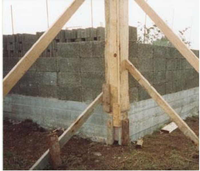
Only Corners Need Bracing Before Pour
