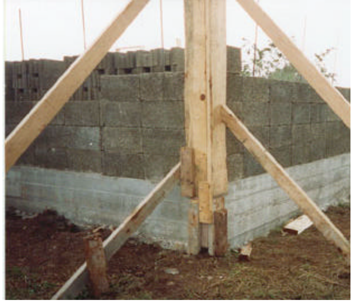
Only Corners Need Bracing Before Pour
